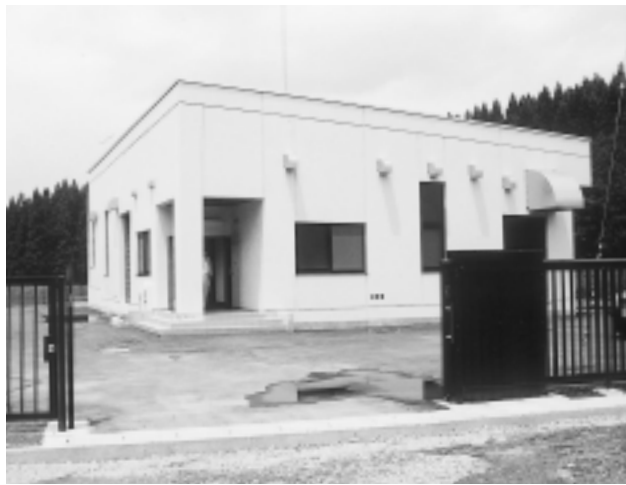
最新設備の六郷東部地区浄水場
