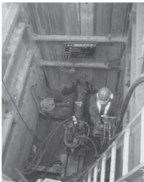
推進工法の状況
