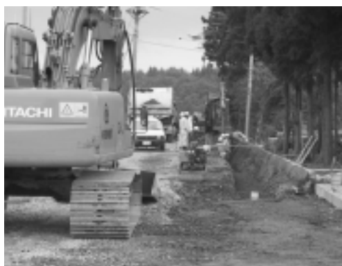
改良工事に伴う水道管移設工事
