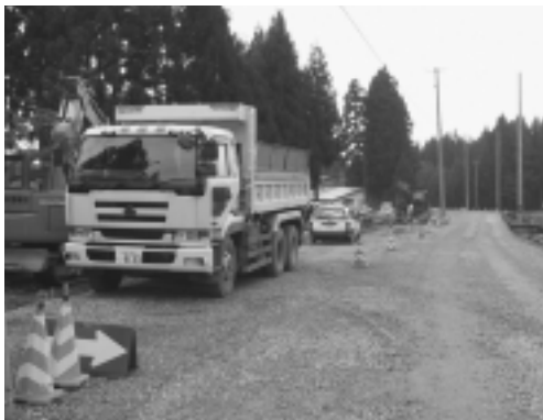
大坂善知鳥外川原線の改良工事
