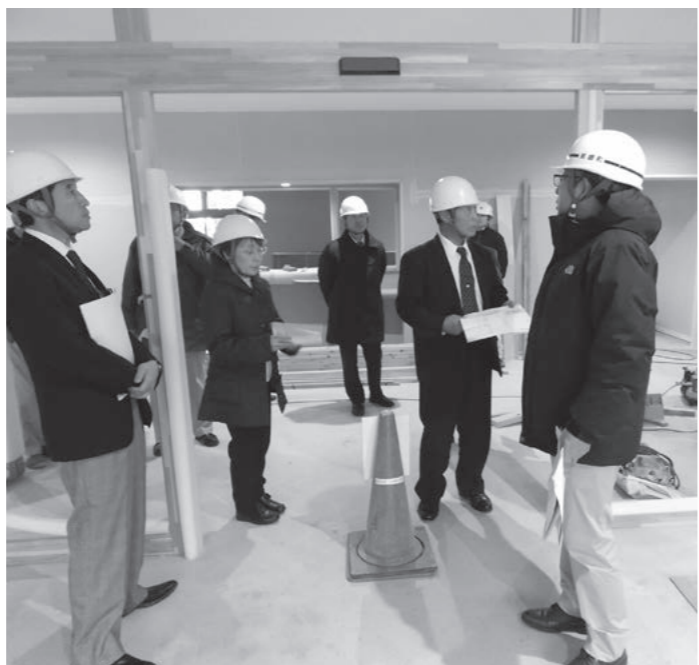
工事中の宿泊交流施設
