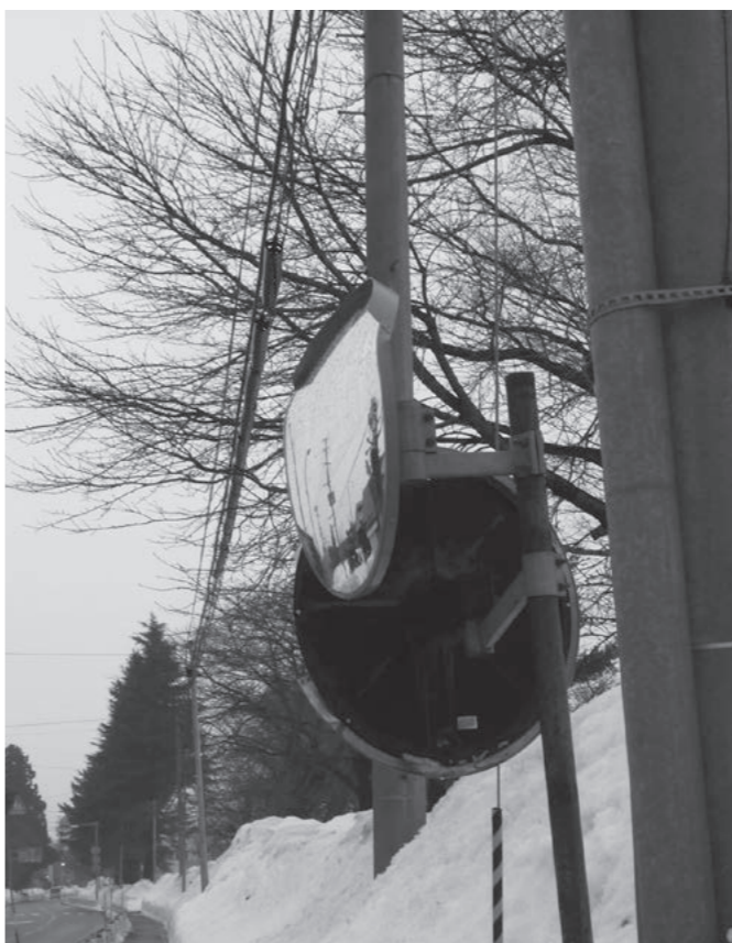
雪で変形したカーブミラー
