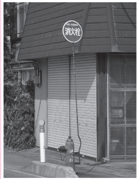
「安全・安心プロジェクト」 改修を予定している六郷地区の消火栓
