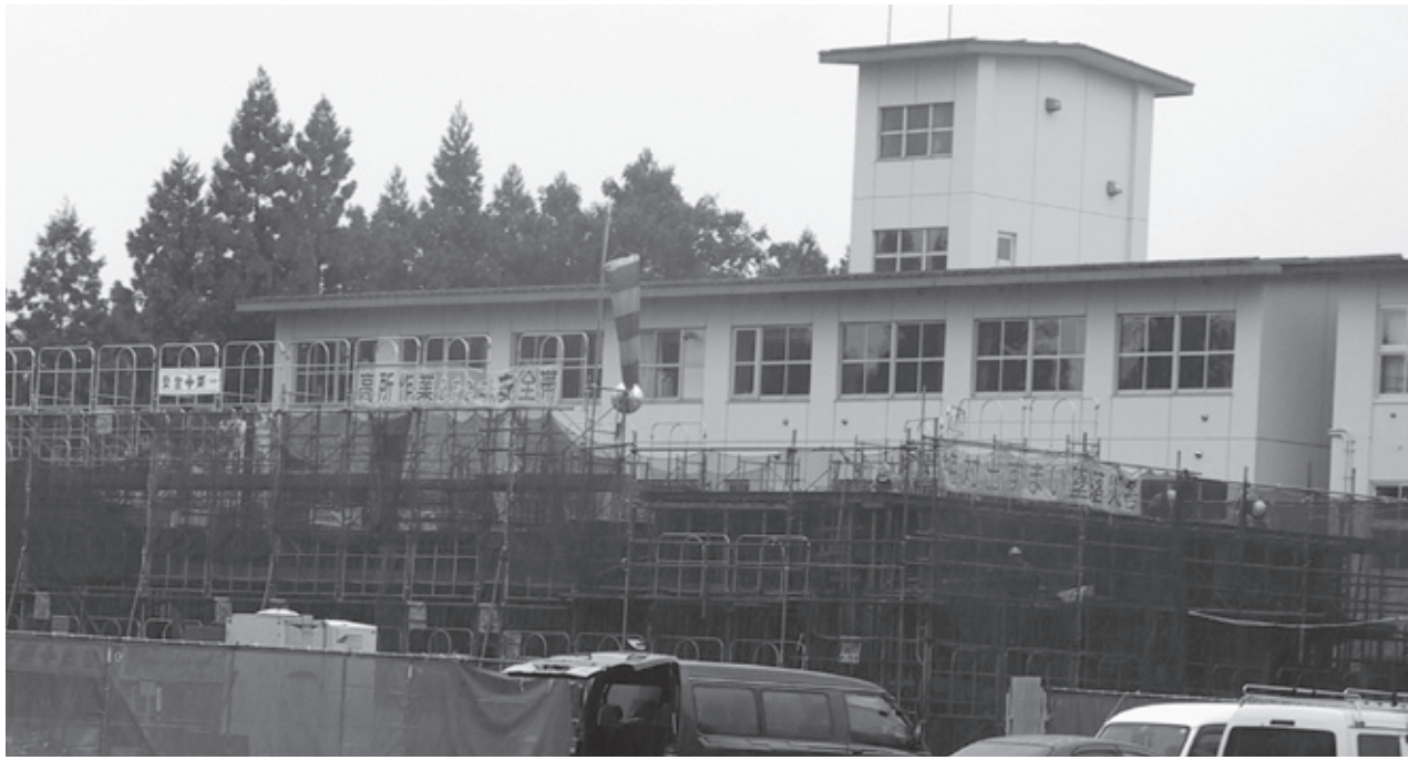
美郷中学校として増築工事が進む六郷中学校
