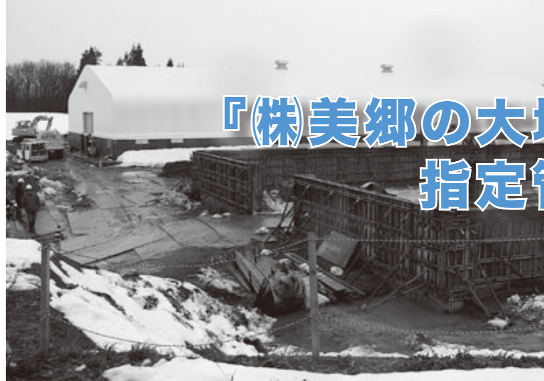
現在建設中の堆肥センター
