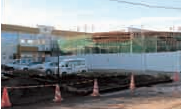
▲統合に向けて増築工事が進む現六郷中学校校舎
