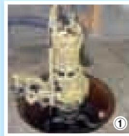
油まみれになった水中ポンプ(写真①)と油まみれのマンホール内(写真②)
