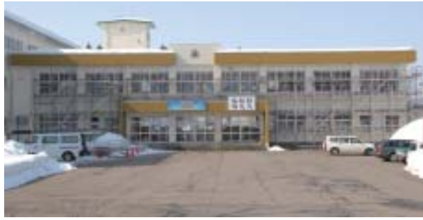
▲工事が進められる六郷中学校校舎
