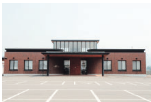
▲保健センター機能を集約する六郷保健センター
