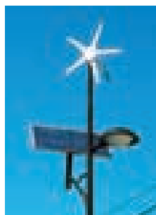
六郷小学校前などに設置している風力と太陽光を利用した街路灯
