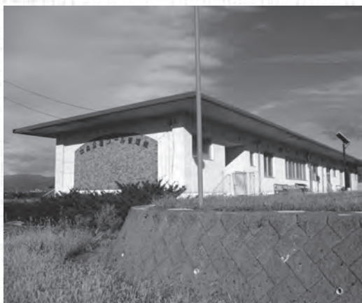
解体する旧中央公園プール管理棟
