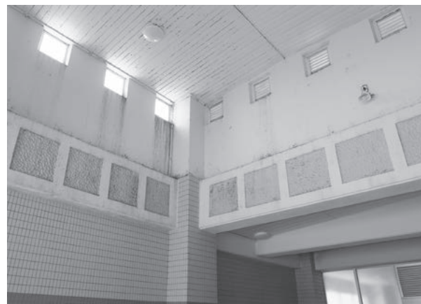
湯とびあ雁の里温泉の浴室天井
