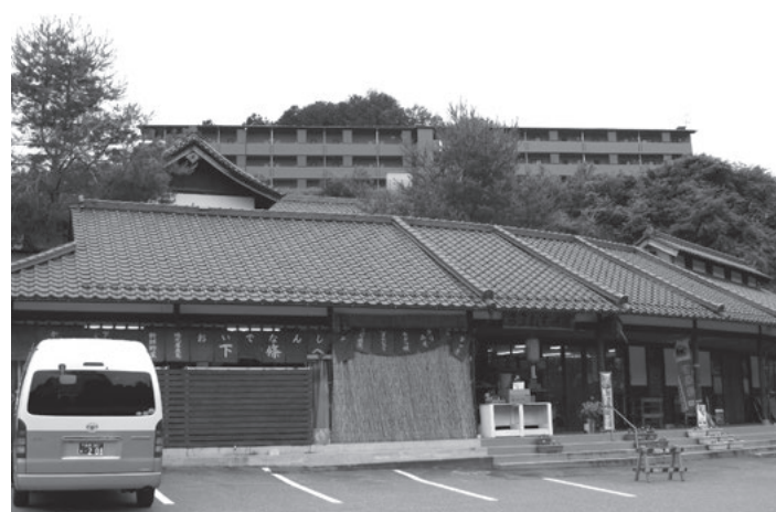
直売施設(手前)と若者専用住宅(奥)
