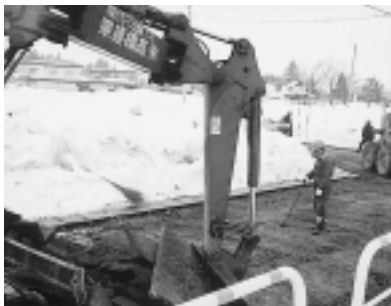
町道の舗装作業
