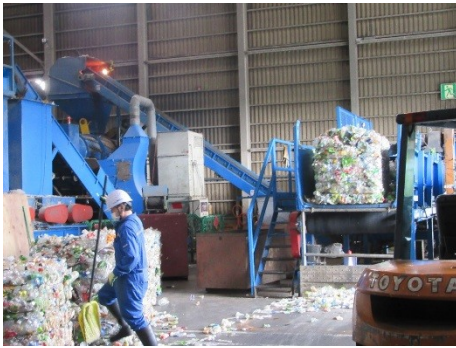
処理設備投入口
