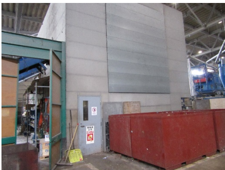
破砕作業 (破砕機室)
