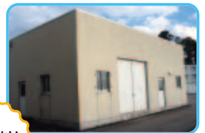
▲六郷下水真空ポンプ場
