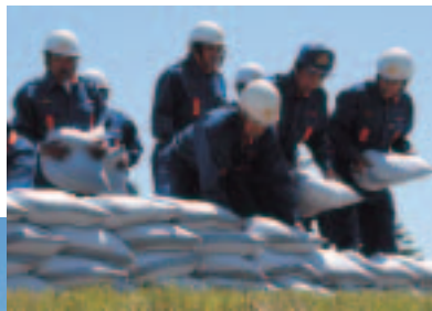
◀積土のう工を行う 仙南地区の団員
